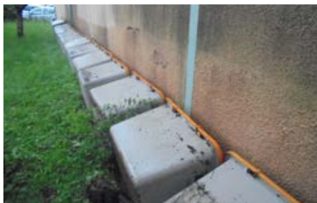
Exemple de bacs de stockage rangés de façon à limiter la rétention d'eau de pluie
