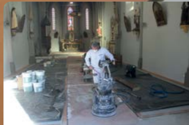
Pose du plancher chauffant.
