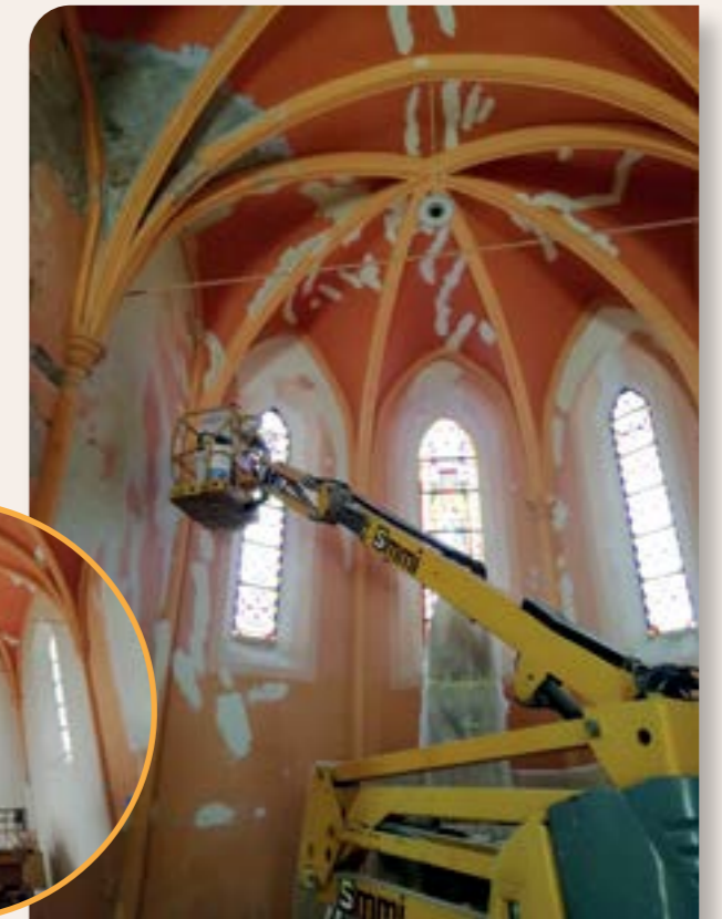
Des moyens importants sont mis en œuvre avec l'utilisation de deux nacelles afin de permettre de travailler dans des endroits difficiles d'accès.
