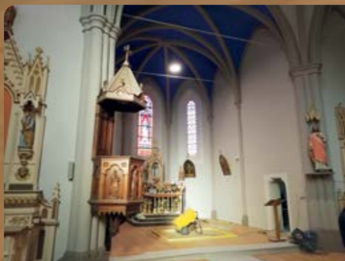
Pose du plancher en chêne avant son vernissage. Ponçage des allées afin d'appliquer un béton ciré du plus bel effet.
