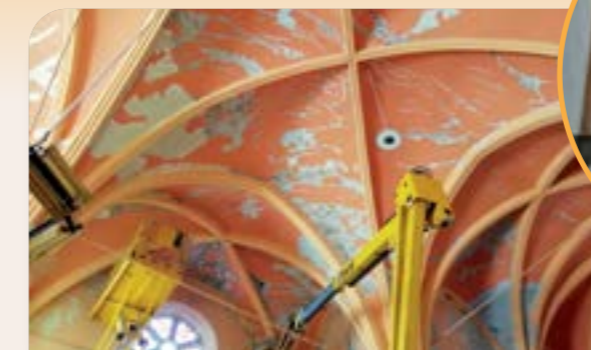
Des moyens importants sont mis en œuvre avec l'utilisation de deux nacelles afin de permettre de travailler dans des endroits difficiles d'accès.
