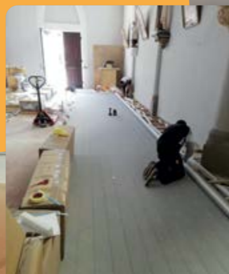
Pose du plancher chauffant.
